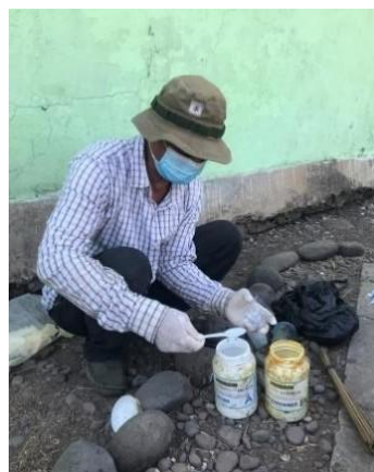
(1) Pembersihan patahan gunung; (2) Pencampuran lem epoksi resin; (3) Peeketan gunung yang patah
